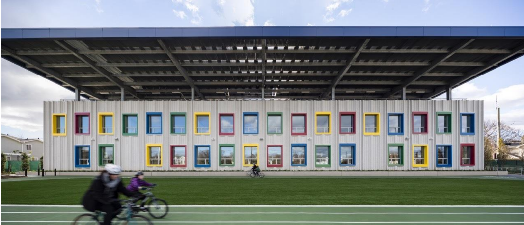
شكل (4.9): فتحات الأسقف وفتحات النوافذ الكبيرة تسمح بتغلغل ضوء النهار إلى فراغات المدرسة الداخلية (المصدر: 2016: The Kathleen Grimm School)
