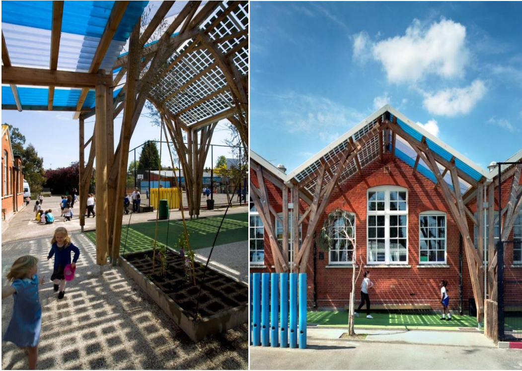
شكل (4.7): الخلايا الكهروضوئية الشبه شفافة توفر الظلال للطلبة للتنقل واللعب في الممرات
