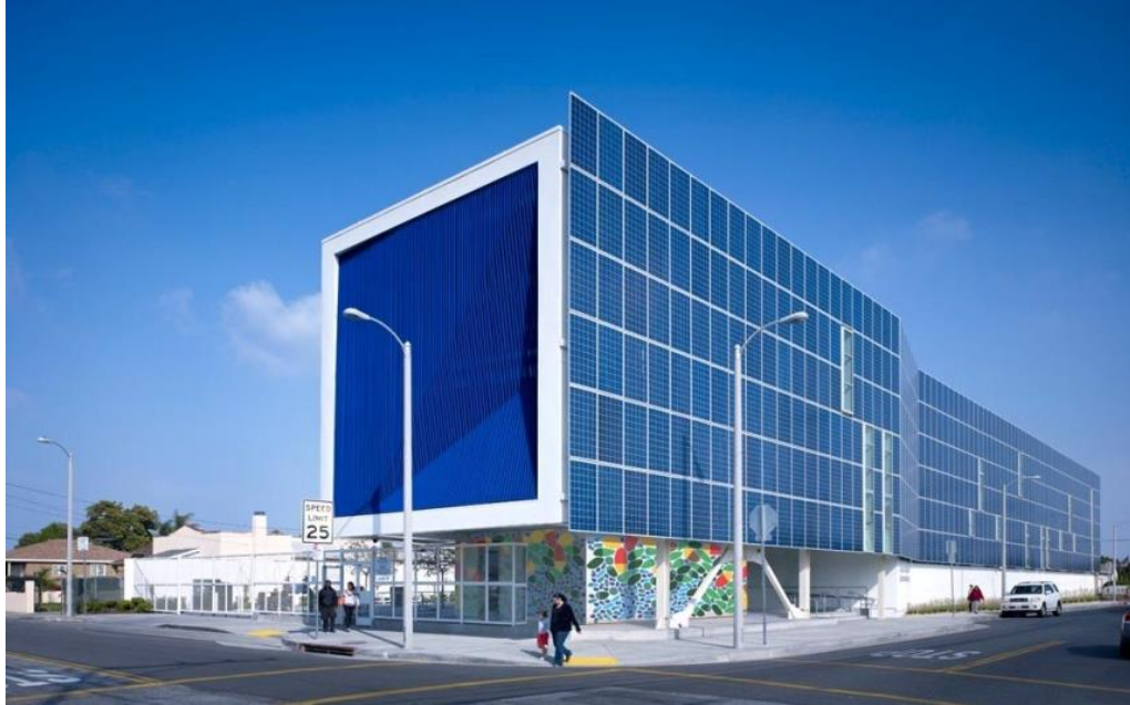
شكل(4.4): تكامل الخلايا كهروضوئية مع الواجهة الجنوبية للمدرسة
