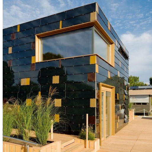
أنظمة الوحدات الكهروضوئية في الحوائط الرأسية لأحد المنازل في ألمانيا
