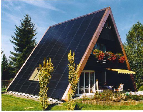
أنظمة الوحدات الكهروضوئية مع الأسقف المائلة لأحد المنازل في بريطانيا
