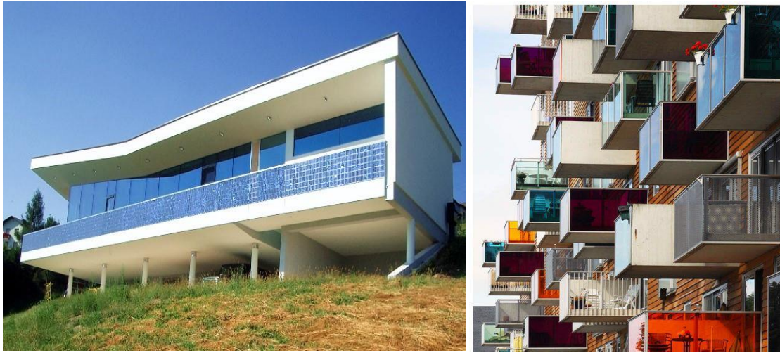
شكل (2.14): استخدام الوحدات الكهروضوئية في درابزين التراسات والبلكونات
