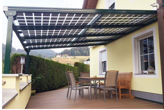
شكل (2.13): استخدام الوحدات الكهروضوئية كمظلات للتراسات والبلكونات
