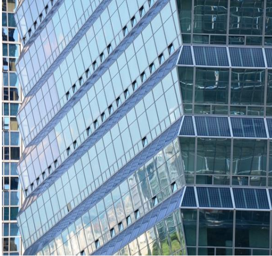
أنظمة الوحدات الكهروضوئية في الحوائط المتدرجة في مبنى اتحاد الصناعات الكورية في كوريا الجنوبية
