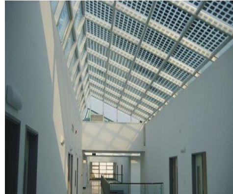
أنظمة الوحدات الكهروضوئية مع الأسقف السماوية في مبنى في كندا
