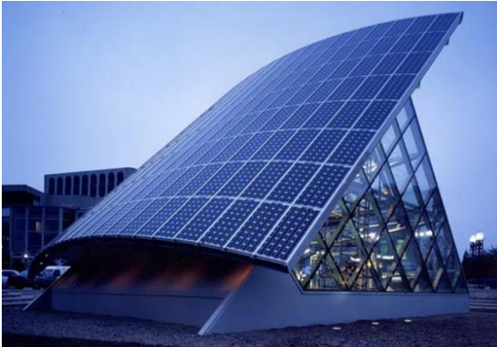
أنظمة الوحدات الكهروضوئية مع الأسقف المنحنية لمبنى في بريطانيا
