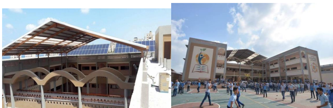
شكل(3.9): أحد مشاريع الإغاثة الاسلامية، مدرسة سعاد الصباح التي إنشاؤها عام 2017 وتم تزويدها بوحدات كهروضوئية على سطحها
